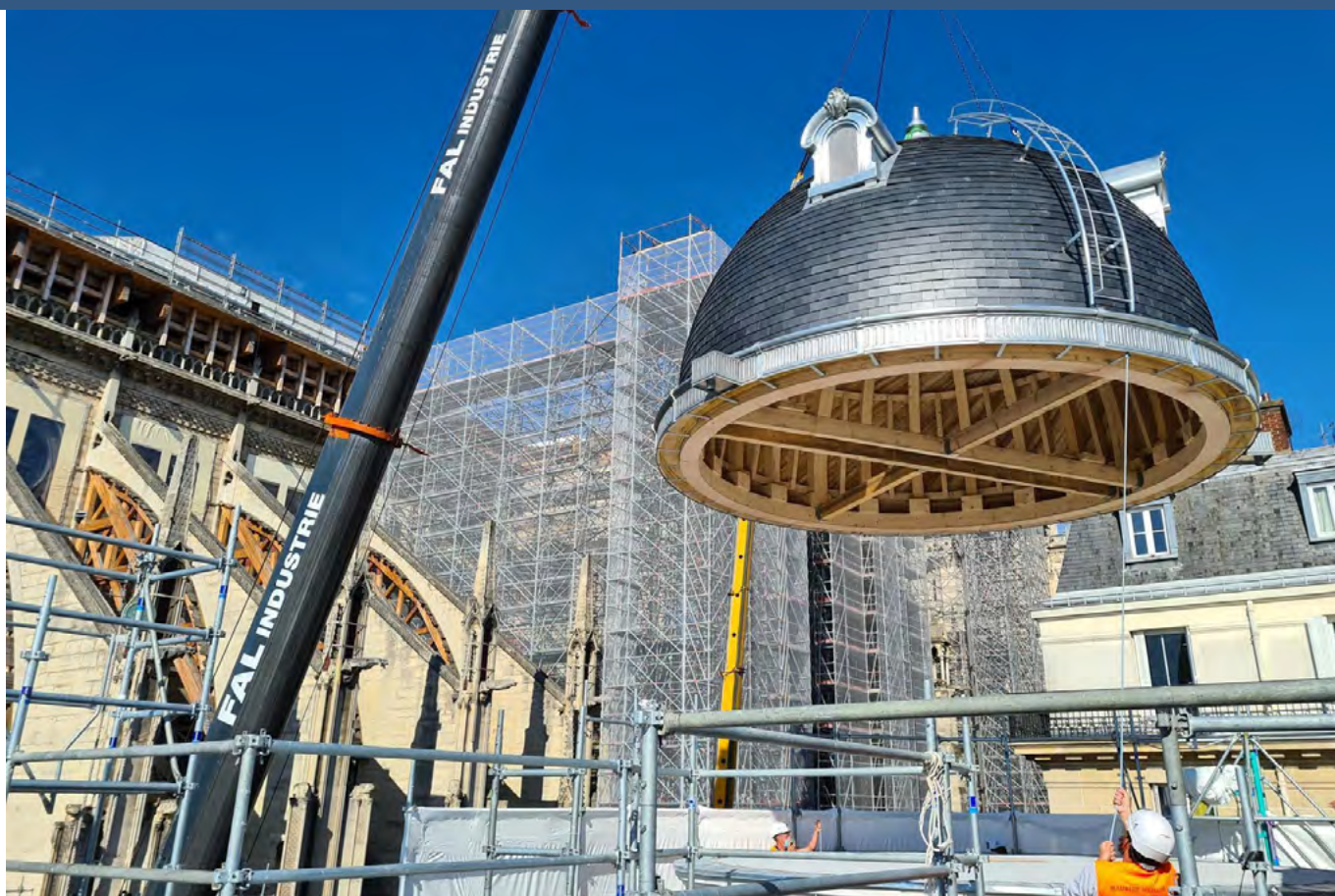
MAURICE NAILLER - RESTITUTION À L'IDENTIQUE DE DÔMES D'AVANT DU XIX e SIÈCLE, D'APRÈS ARCHIVES © MAURICE NAILLER
